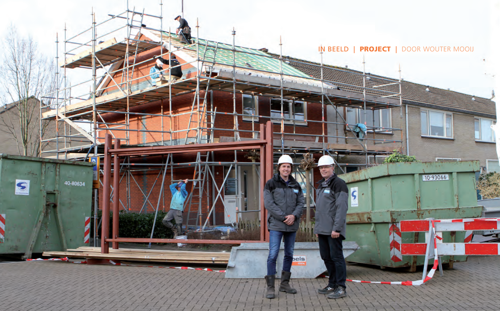
▲ Sander Willems (links) en uitvoerder Arie van der Meer voor een kopwoning die in vijf dagen tijd wordt opgewaardeerd van energielabel E naar A.
