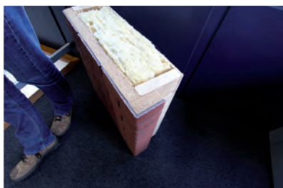
► Opbouw van de geïsoleerde prefabgevel met steenstrips.
