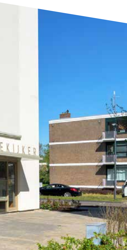
Energielabel F naar A+++: Appartementen Koelmalaan, Alkmaar Renovatie met een Alsecco gevelisolatiesysteem, pleister, minerale steenstrips en decoratieve Faceboard profielen.
