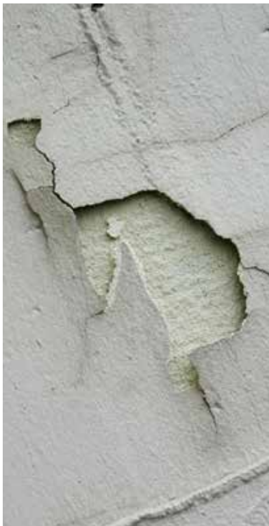
Probleem: de afwerk- en wapeningslaag op polystyreenisolatie is over het gehele oppervlak beschadigd en moet worden vervangen.
