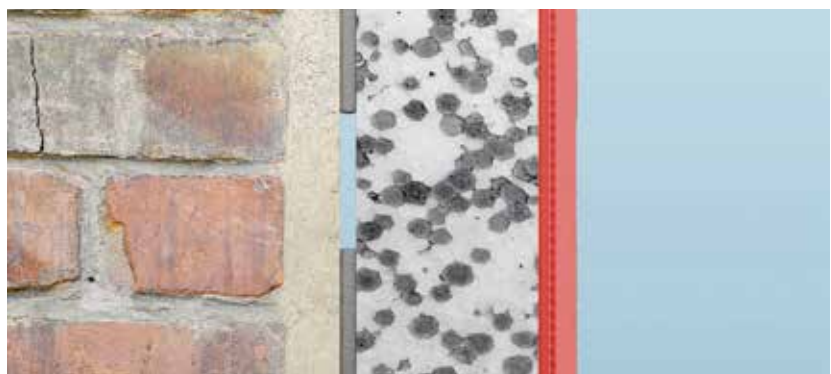
Oplossing: volledige vervanging van de pleisterlaag.
